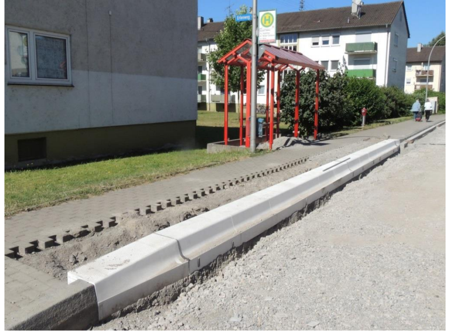
Hammerweg – Haltestellen im Bau
