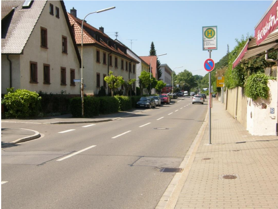
Umbau der Haltestelle Henschelberg
