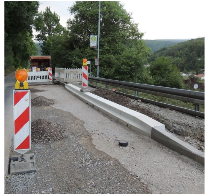
Maßnahme Alte Bergsteige im Bau
