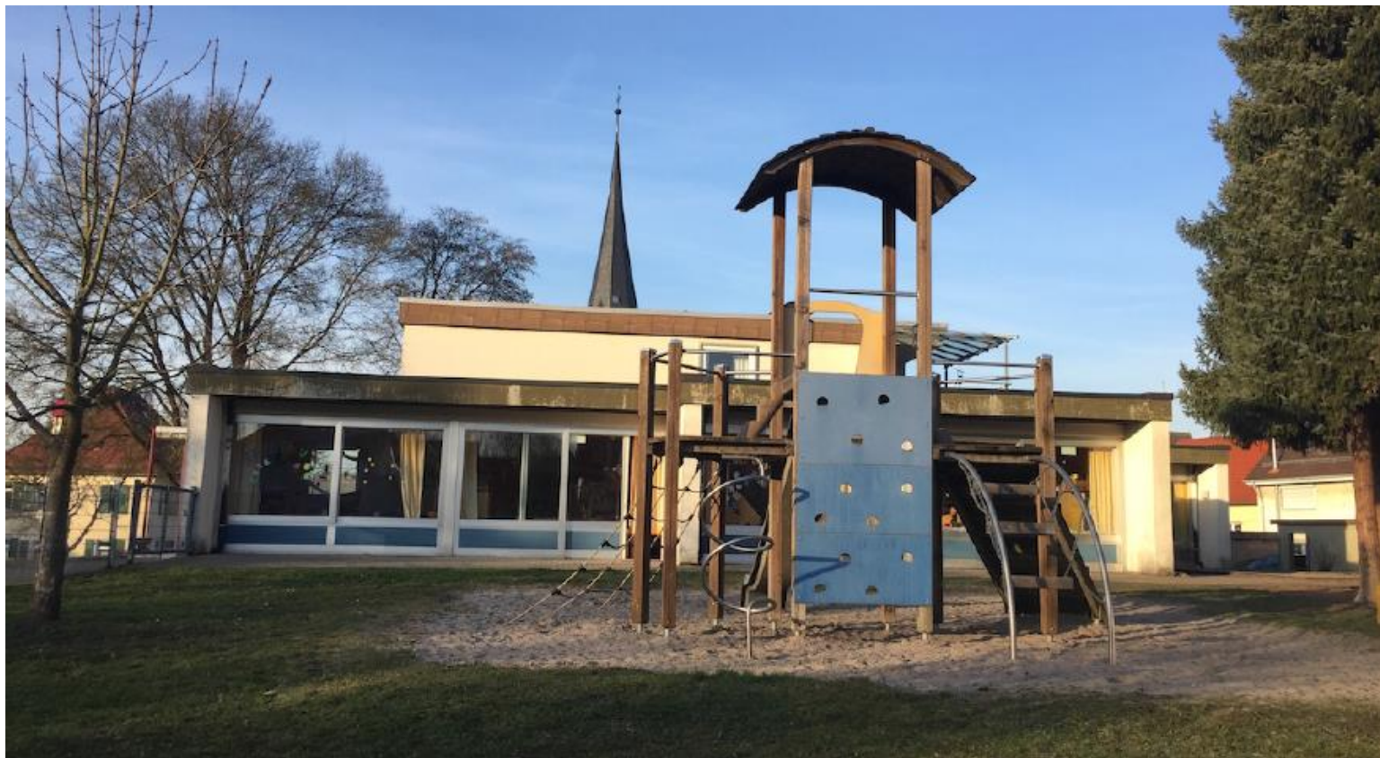
Bestandsgebäude evangelischer Kindergarten Neckarelz
