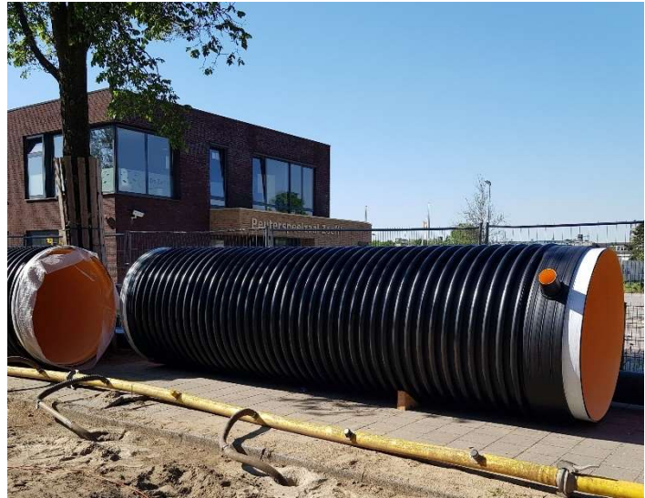
Abb. 5 „Thermpipe“® mit Stützrohr am Außenrohr für Neuverlegung (Frank GmbH)
